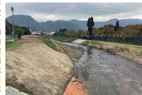
河川改修が急がれる野呂川
